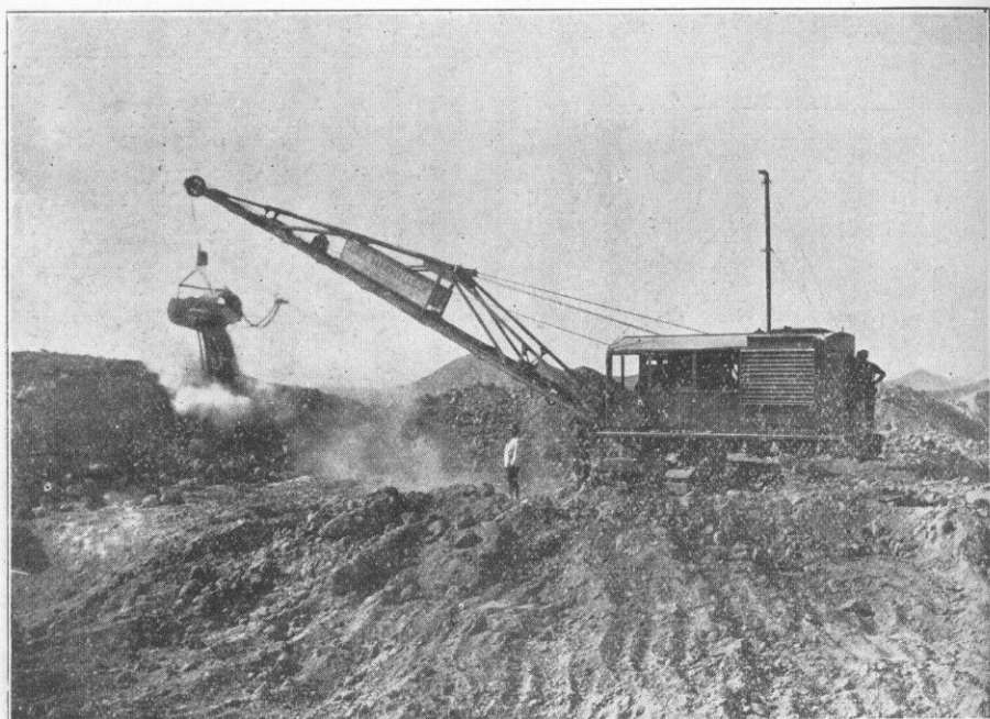
Carguío mecánico del caliche
