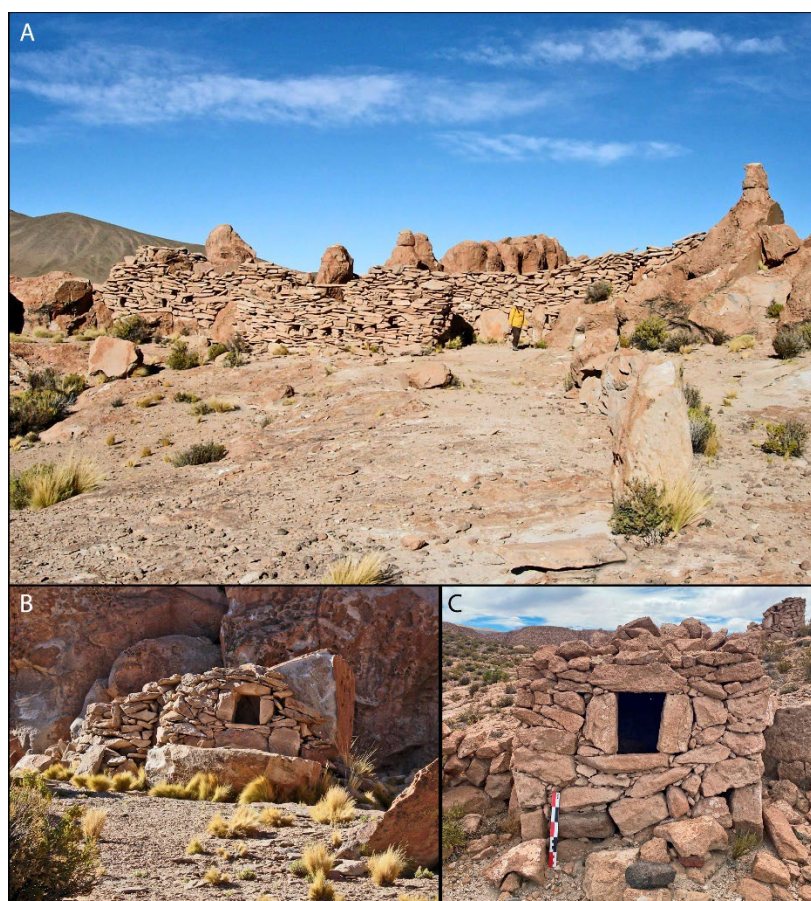
Figura 2. Vista general del sitio Mallku, chullpas y V. Castro al fondo. (a-b) Bolivia (gentileza de V. Varela), (c) Chullpa de Toconce (gentileza de C. González).
