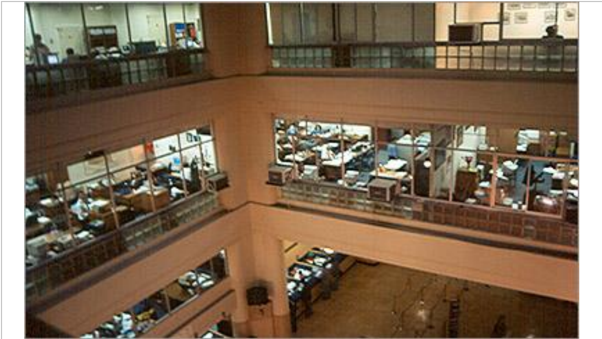
Figura13. Vista actual de zonas de trabajo en diversos pisos, donde se aprecia ocupación de áreas de circulación originales, y cerramiento del espacio en el plano perimetral del hall central. Edificio de la ex Caja de Crédito Agrario.
