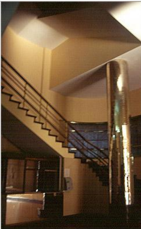
Figura16.- Vista de columna junto a escalera del edificio de la ex Caja de Crédito Agrario.
