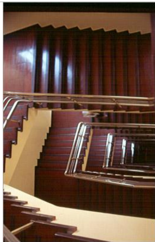
Figura15.- Vista del vacío central de escalera principal del edificio de la ex Caja de Crédito Agrario.
