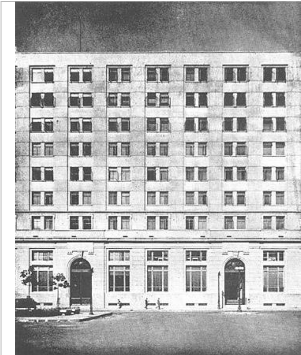
Figura1. Vista de la fachada principal del edificio de la ex Caja de Crédito Agrario, 1940.
