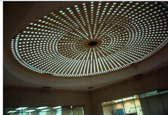
Figura12. Vista actual del lucernario del hall central del edificio de la ex Caja de Crédito Agrario, desde el piso superior.
